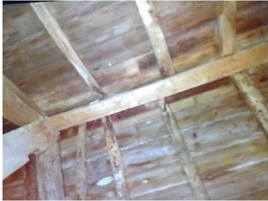
Combles Combles étage 1
