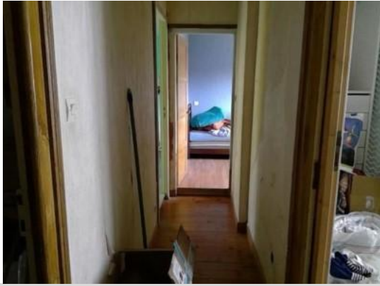
1er étage Couloir
